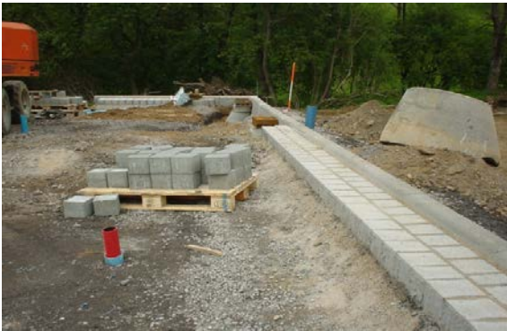
Einbau von Rinnen und Bordsteinen Foto während der Bauphase
