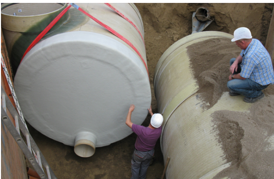
Staukanäle DN 2500 GFK Foto während der Bauphase
