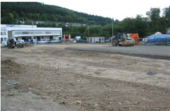
Vorbereiten der Oberflächenabdeckung aus Asphalt Foto während der Bauphase
