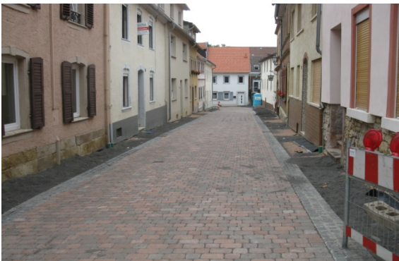
Verkehrsflächen Altstadtpflaster, Rinne aus Natursteinen Foto während der Baumaßnahme
