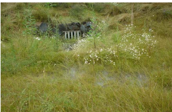
Einlauf in die Mulde nach einem Regenereignis Foto ca. 5 Jahre nach Fertigstellung
