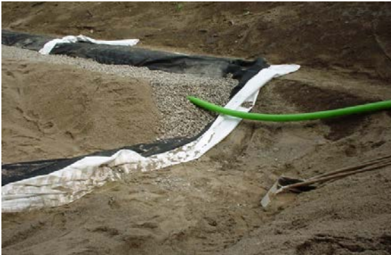
Beetaufbau Foto während der Bauphase
