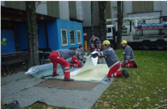
Vorbereiten eines Kurzliners
