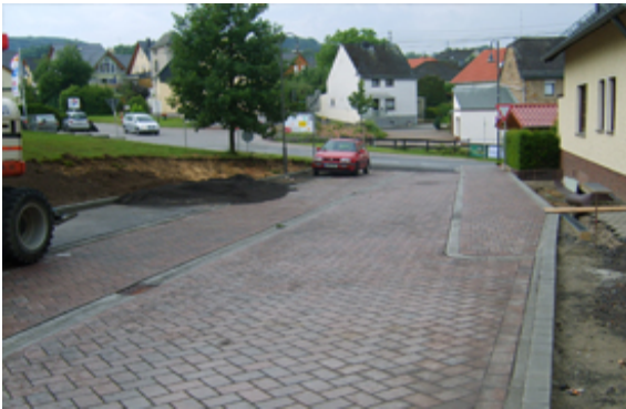
Verkehrsflächen in Altstadtpflaster Foto während der Bauphase
