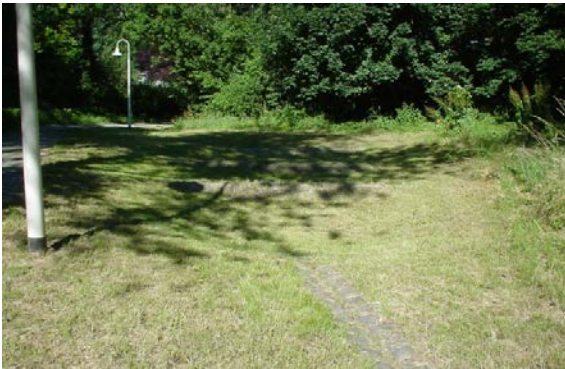
Versickerungskaskaden mit Überlauf Foto ca. 2 Jahre nach Fertigstellung
