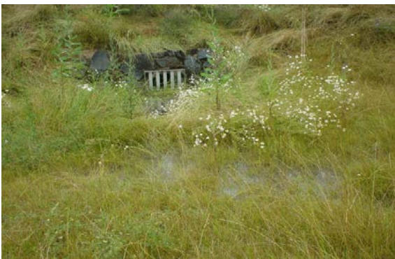
Einlauf in die Mulde nach einem Regenereignis Foto ca. 5 Jahre nach Fertigstellung
