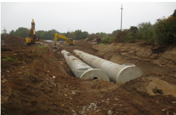
Verlegung Stauraumkanal Foto während der Bauphase
