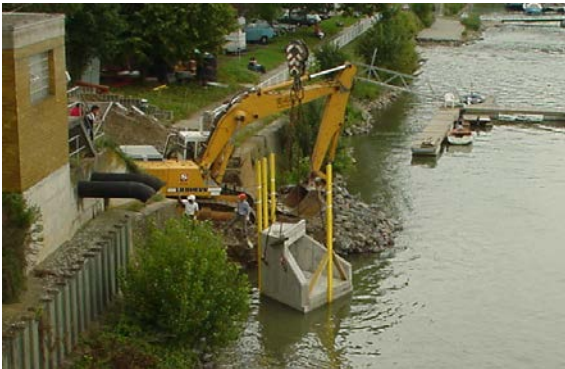
Setzen des Einlaufbauwerks (Fertigteil) in den Rhein Foto während der Bauphase
