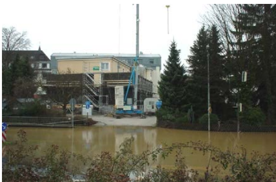
Hochwassergefahr auf der Baustelle
