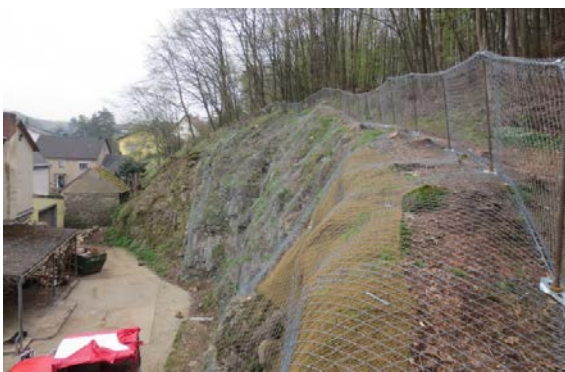
Felsböschung mit Netzverhängung und Steinschlagschutzzaun Foto ca. 3 Monate nach Fertigstellung
