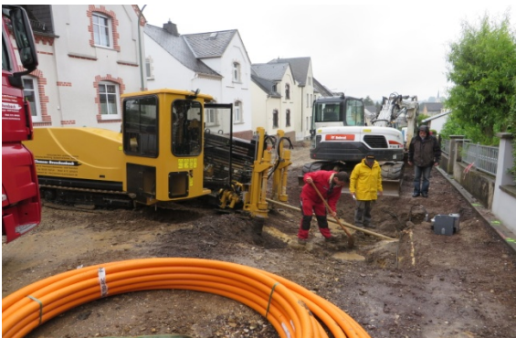
Hausanschluss mittels Spülbohrverfahren Foto während der Bauphase
