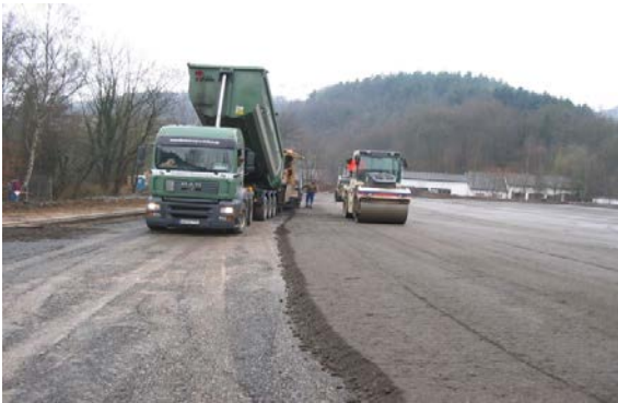
Einbau der Oberflächenabdichtung aus Asphalt Foto während der Bauphase
