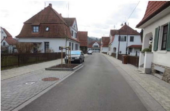
Gehwege und Parkplätze in Altstadtpflaster, Fahrbahn in Asphalt Foto ca. ein 1/2 Jahr nach Fertigstellung
