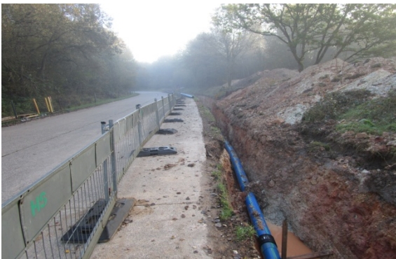
Rohrverlegung Foto während der Bauphase
