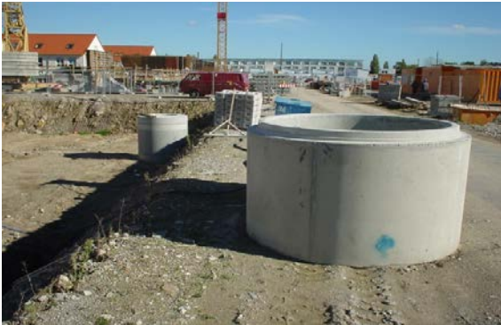
Einbau von Versickerungsschächten DN 2000 Foto während der Bauphase
