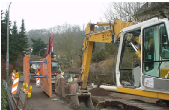
Aushub des Kanalgrabens Foto während der Bauphase
