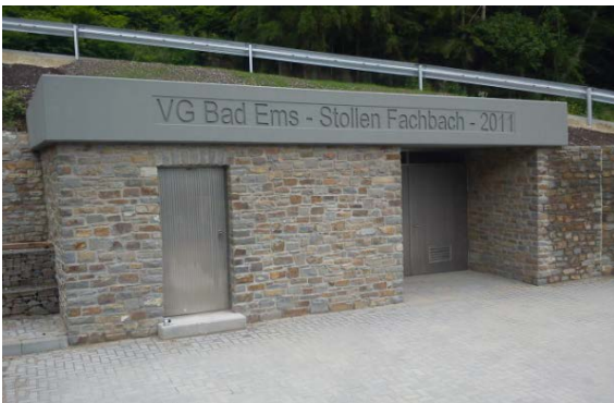
Fertiggestelltes Stollenportal Foto ca. 1 Jahr nach Fertigstellung 1. BA
