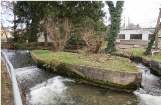
Gewässerabschnitt mit Wehranlage Foto zur Bestandsaufnahme
