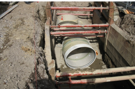
Errichtung eines Fertigteilschachtes Foto während der Bauphase
