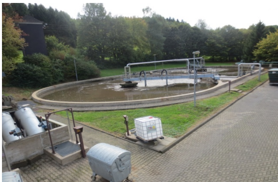
Planung Belüftungseinrichtung Foto zur Bestandsaufnahme
