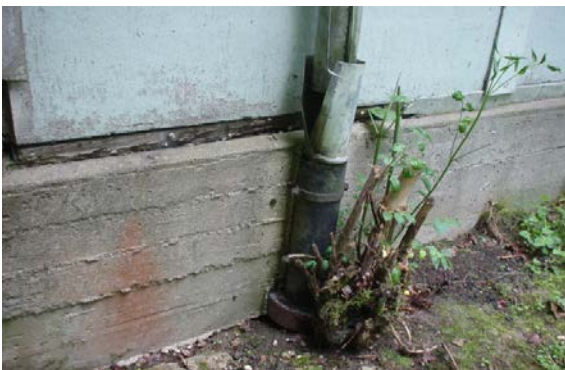
Wurzelnwuchs im Bereich eines Regenfallrohrs Foto zur Bestandsaufnahme
