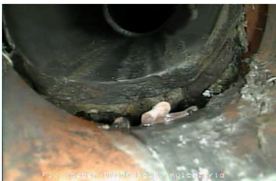
Zu sanierender Muffenversatz
