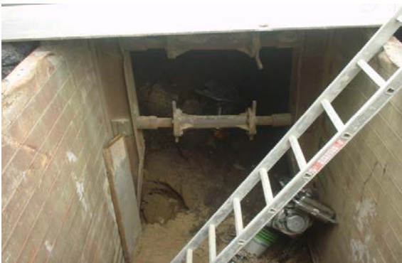
Verbauelemente im Kanalgraben Foto während der Bauphase
