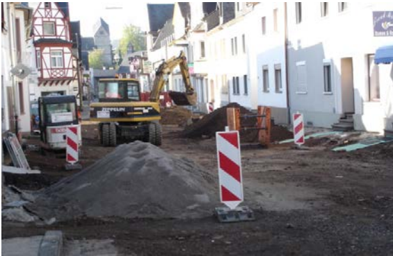
Tiefbauarbeiten zwischen Wohngebäuden Foto während der Bauphase
