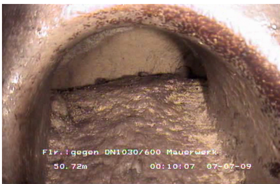
Zu verschließender Rattenbau
