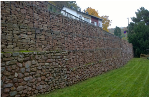
Stützwand zur Straße in Kombination aus Natursteinmauer und Gabionen Foto ca. 4 Jahre nach Fertigstellung
