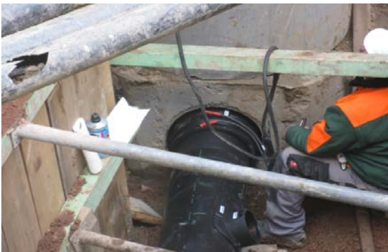
Vorbereiten der Schweißverbindung Foto während der Bauphase
