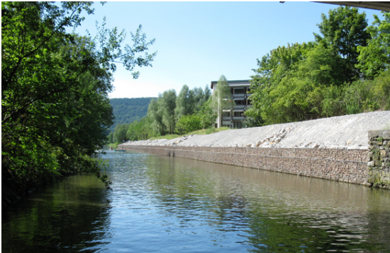
Gabionenwand mit Böschung aus Magersubstrat/Eidechsenbiotop Foto ca. ein Monat nach Fertigstellung
