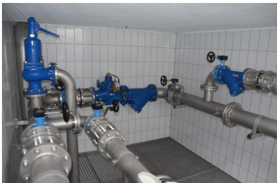
Druckminder- und Wasserzählschacht Foto ca. ein 1/2 Jahr nach Fertigstellung
