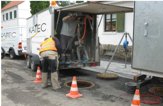
Vorbereitungsarbeiten zur Kanalsanierung
