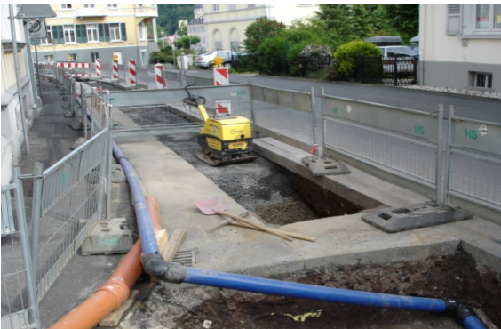
Grabenverfüllung und Notwasserversorgung
