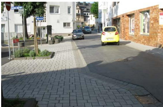
Gehweg in Pflaster, Fahrbahn in Prägeasphalt Foto ca. 1 Jahr nach Fertigstellung
