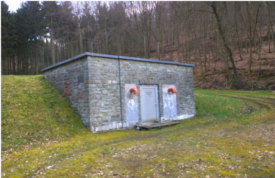
Behältereingang vor der Sanierung Foto zur Bestandsaufnahme
