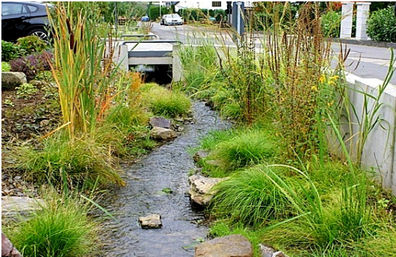
Renaturierte Bachführung in Ortslage Foto ca. 2 Jahre nach Fertigstellung
