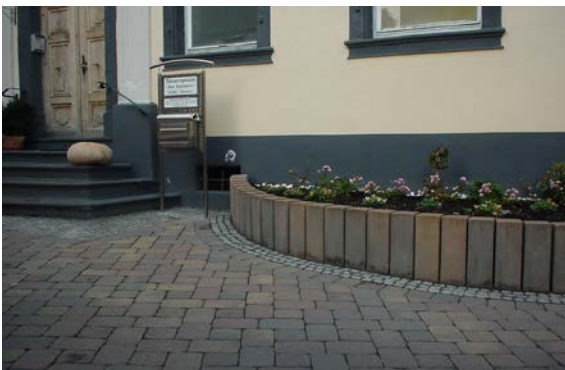
Randbefassung und Pflanzbeet Foto nach Fertigstellung
