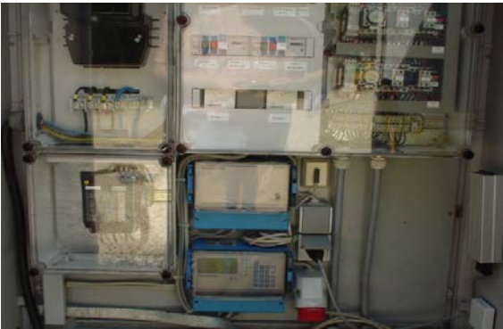
Schalt- und Steuereinrichtung Foto nach Fertigstellung
