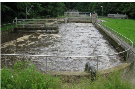
Vorhandenes Belebungsbecken Foto zur Bestandsaufnahme
