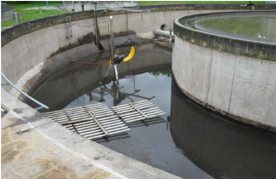
Nachklärung Foto zur Bestandsaufnahme
