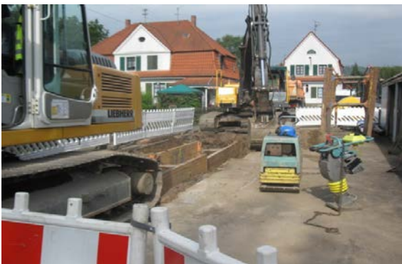
Aushub des Kanalgrabens Foto während der Bauphase
