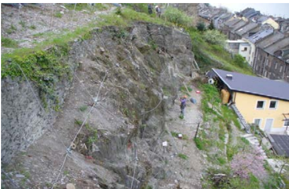
Netzverhängung der Böschung Foto während der Bauarbeiten
