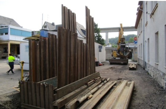
Aushub des Kanalgrabens Foto während der Bauphase
