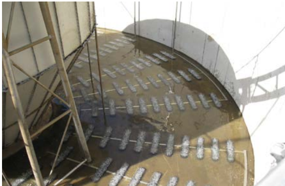
Plattenbelüfter Foto zur Bestandsaufnahme
