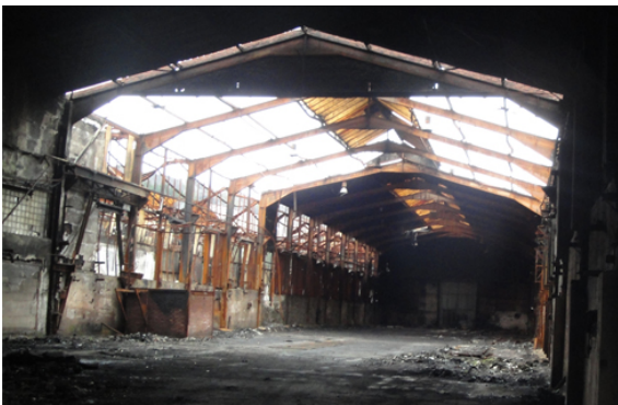
Halle mit Schadbelastungen nach einem Großfeuer Foto vor dem Hallenabbruch
