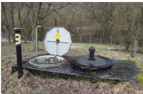
Zugang Tiefbrunnen Foto zur Bestandsaufnahme vor der Sanierung
