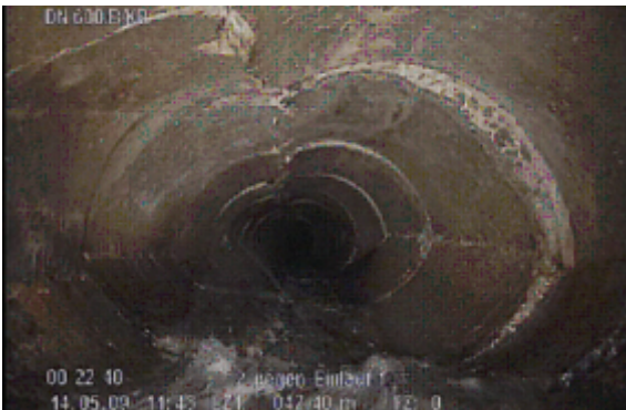
Rohreinbruch Schadensklasse 0 - Sofortmaßnahme
