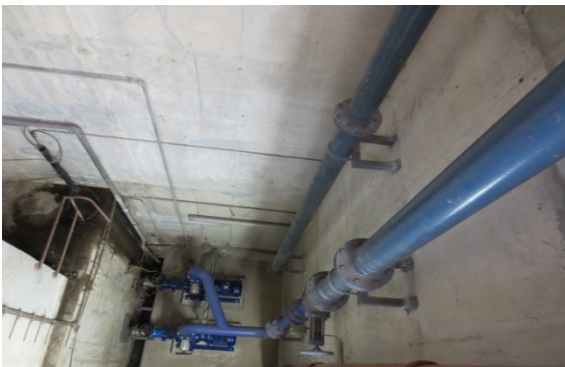
RRB und Quellschacht (Zulauf)
