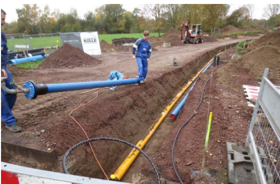
Neuverlegung der Trinkwasserleitung Foto während der Bauphase
