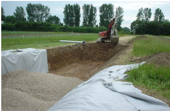
Einbau von Kies in die Rigole Foto während der Bauphase
