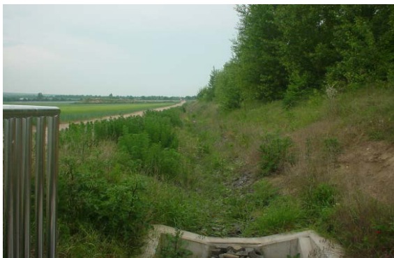
Entwässerungsgraben mit Einlauf in den Sandfang Foto ca. 2 Jahre nach Fertigstellung
