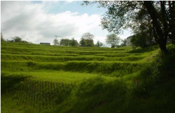
Mulden mit befestigtem Überlauf Foto ca. ein 1/2 Jahr nach Fertigstellung
