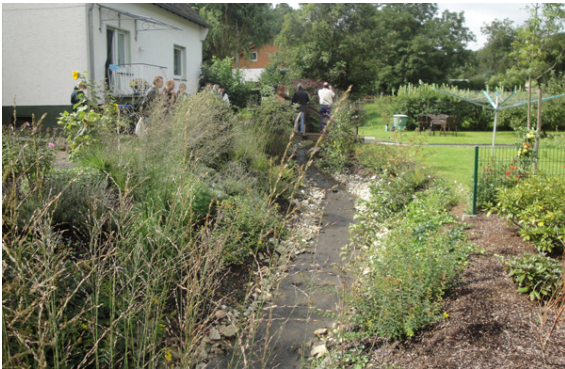
Gewässertrasse nach Rückbau der starren Sohlbefestigung Foto ca. 1 Jahr nach Fertigstellung
