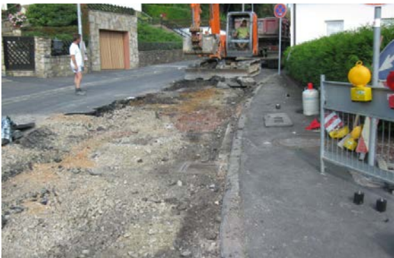
Oberflächenaufruch Asphaltflächen Foto während der Bauphase
