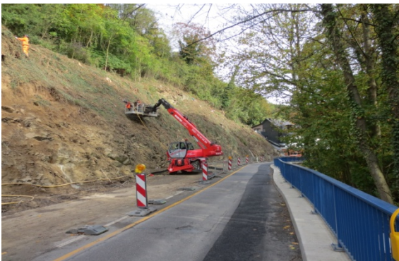
Vorbereiten zur Netzverhängung Foto während der Baumaßnahme
