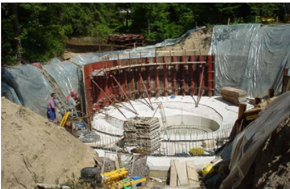
Einbau der Waagedrossel Foto während der Bauphase
