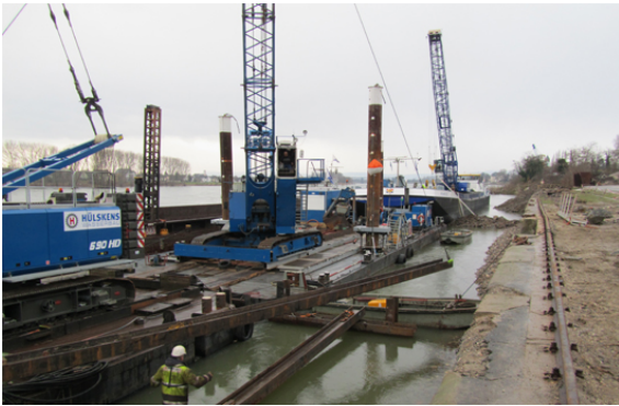
Vorbereitende Arbeiten zum Einbau der Stahlpulwand Foto während der Bauphase
