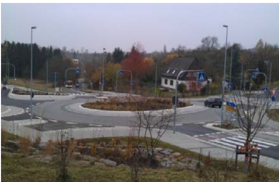
Kreisverkehrsplatz Foto ca. 1 Jahr nach Fertigstellung
