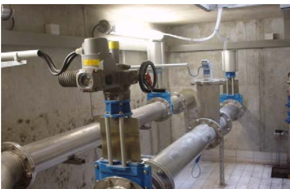
Mess- und Regelschacht mit Messstrecke
