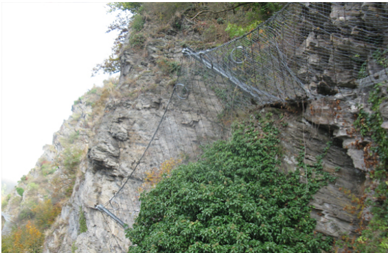
Fangzaunanlage mit Stützen im Fels montiert Foto ca. ein 1/2 Jahr nach Fertigstellung
