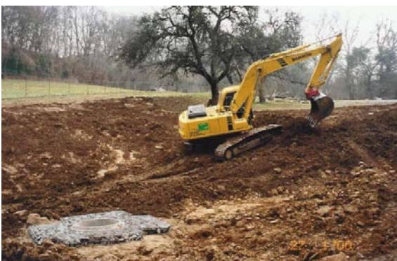
RRB und Quellschacht (Zulauf) Foto während der Bauphase
