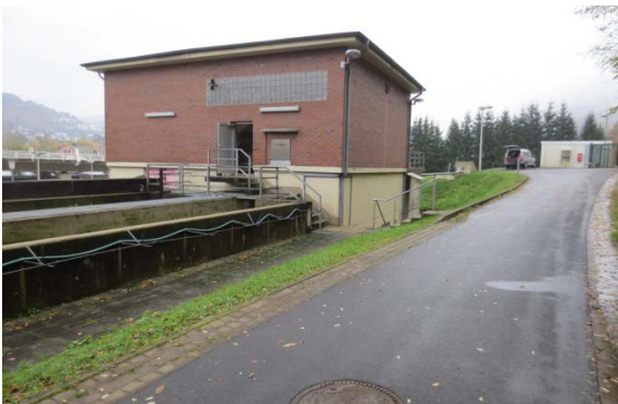
Rechengebäude Foto zur Bestandsaufnahme
