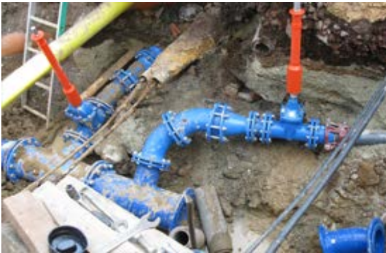
Schieberkreuz DN 250/150 Foto während der Bauphase
