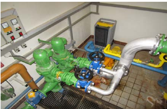
Rohrkeller mit Druckerhöhung Foto zur Bestandsaufnahme
