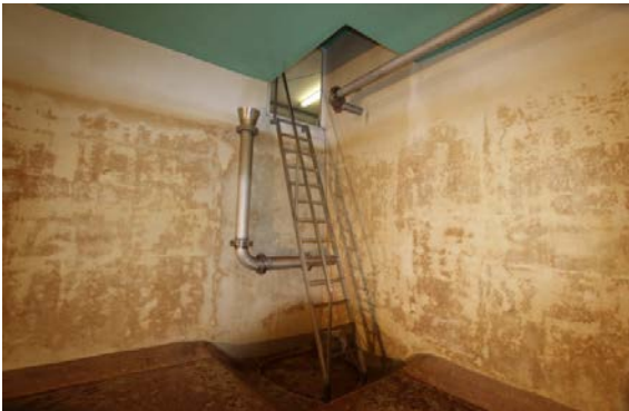
Entleerte Wasserkammer Foto zur Bestandsaufnahme
