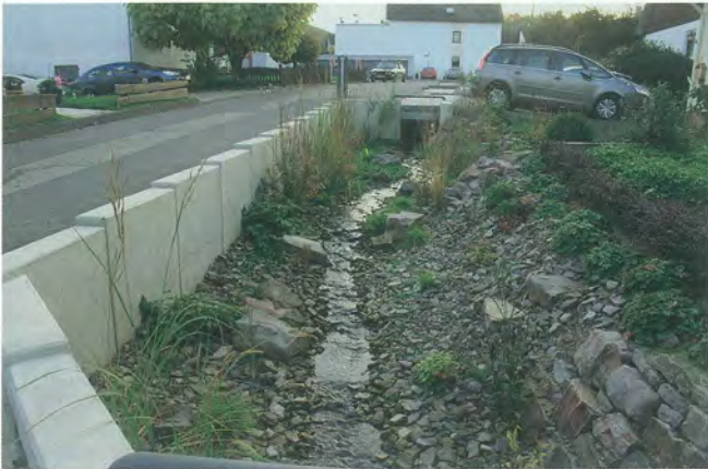
Bild 6: Neu hergestellter, verbreiteter Bereich, etwa 6 Monate nach Fertigstellung (Foto: GASTRING INGENIEURE)
