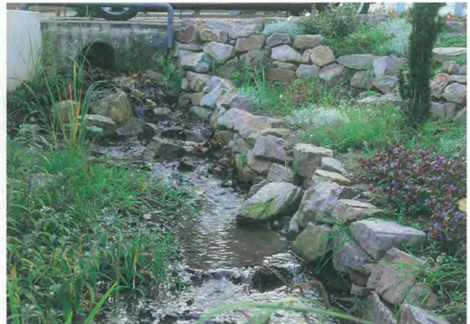
Bild 8: Nachher (Stand 2012) (Foto: GASTRING INGENIEURE)
