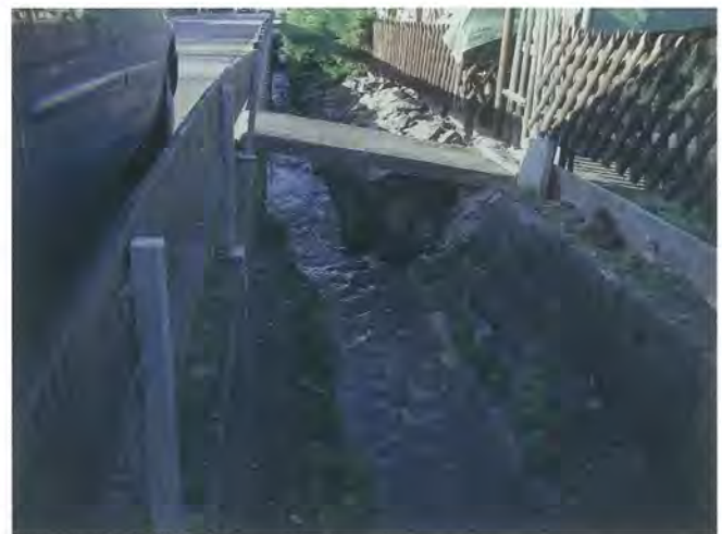
Bild 2: Verbaute Sohle und Böschung vor Renaturierung
