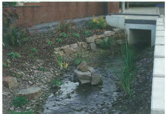
Bild 10: Nachher (Stand 2012) (Foto: GASTRING INGENIEURE)
